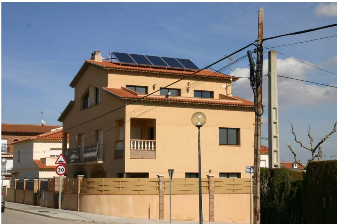
Foto n°94. Plaques solars fototèrmiques situades a la teulada d'un habitatge al nucli de Banyeres
